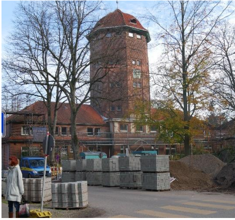
Ehemaliger Wasserturm (Foto: Hans-Joachim Klier)
