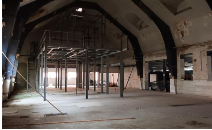
Innenansicht des mit dem Wasserturm verbundenen ehemaligen Waschgebäudes
