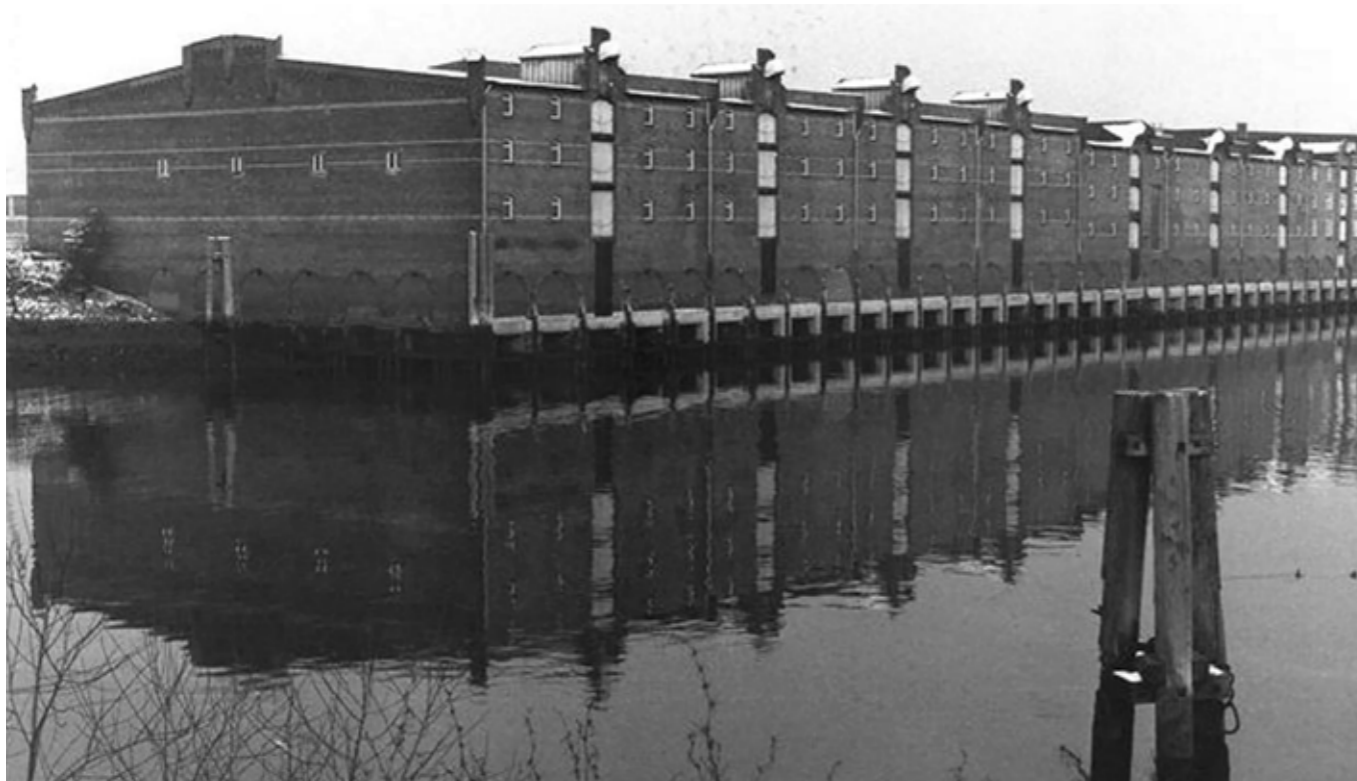
Lagerhaus G am Dessauer Ufer in Hamburg, Kleiner Grasbrook (ehemaliges KZ-Außenlager)
