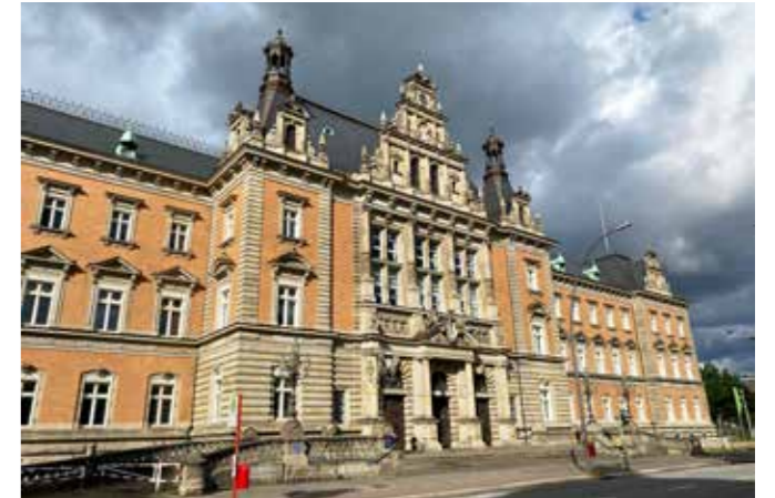
Straßjustizgebäude am Sievekingplatz 3
